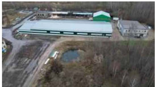
Zemesgrāmatas nodaļījumā neregistrēta jaunbūve (kokmateriālu saaudzēšanas ceha) ar kadastra apzīmējumu 5470 003 0326 011 (saskaņā ar būvvaldes izziņu)
