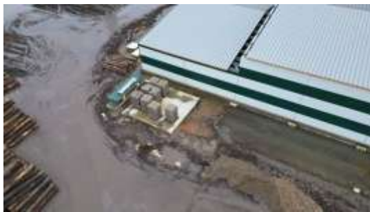
Zemesgrāmatas nodaļumā neregistrēta jaunbūve (kokmateriālu saudzēšanas ceha) ar kadastra apzīmējumu 5470 003 0326 011 (saskaņā ar būvvaldes izziņu)
