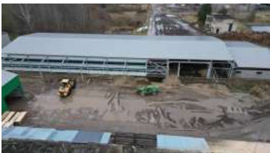
Zemesgrāmatas nodaļījumā neregistrēta jaunbūve (kokmateriālu saaudzēšanas ceha) ar kadastra apzīmējumu 5470 003 0326 011 (saskaņā ar būvvaldes izziņu)
